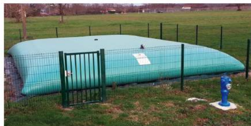
Exemple de citerne souple et point d'adduction
