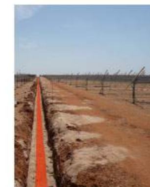
Pose des structures porteuses et raccordement interne
